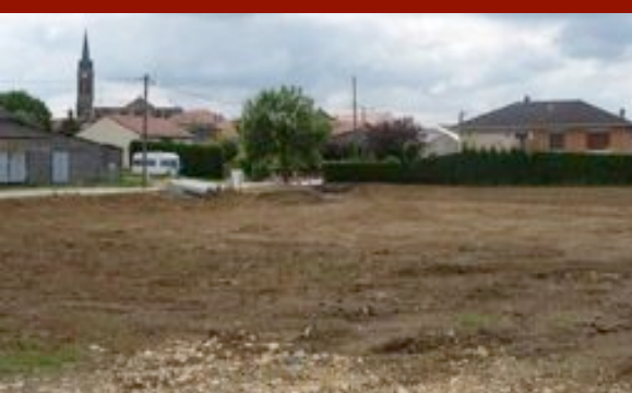
Le chantier des bassins de rétention
