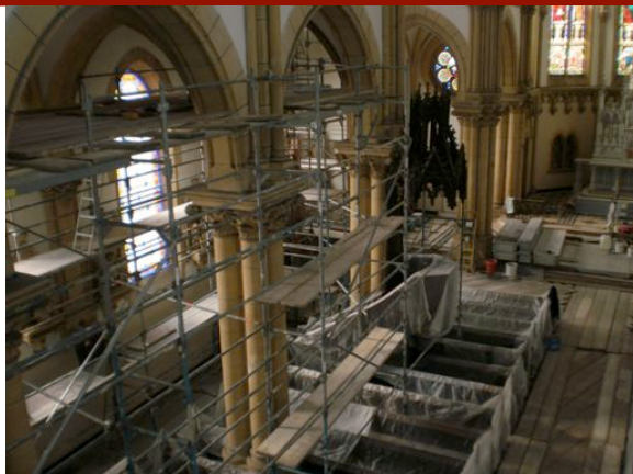
Echafaudages dans l'église
