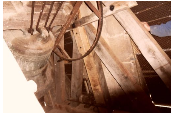
Rénovation du support des cloches de l'église
