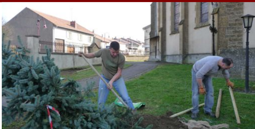
Travaux de plantation près de l'église
