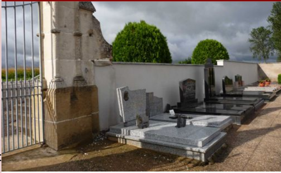
Le mur et les tombes endommagés reconstruits à neuf
