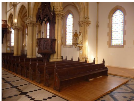
... et après les travaux
